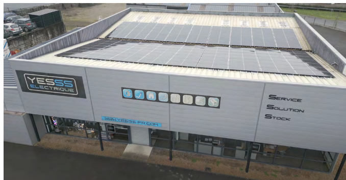
YESSS Electrique équipe progressivement ses agences de panneaux photovoltaïques comme ici à Châteaubriant.
